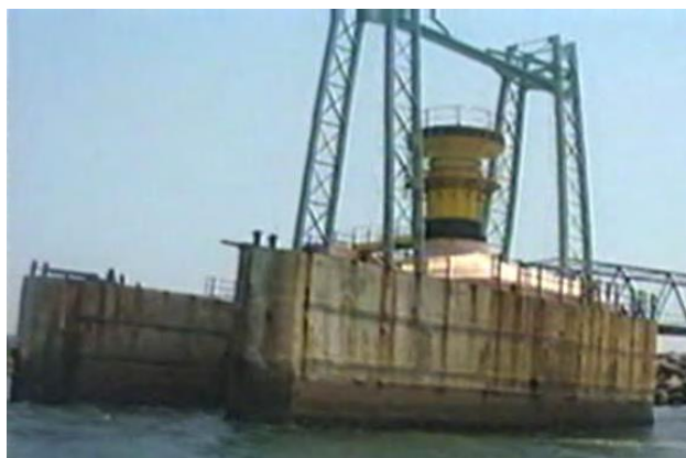
3.1. att. Indiānas viļņu enerģijas pārveidotājs (OWC) [37].
