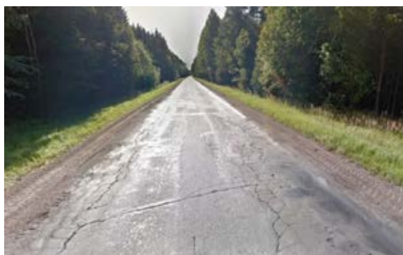
3.30. att. Skats uz autoceļa P35 12. km segumu ( IRI 6,5 mm/m).
