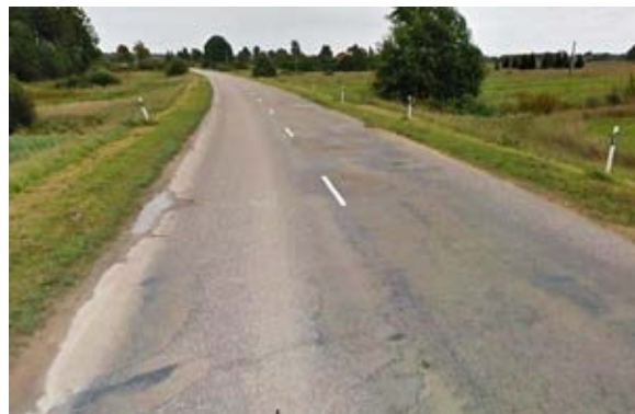
3.29. att. Skats uz autoceļa P4 30. km segumu ( IRI 4,8 mm/m).
