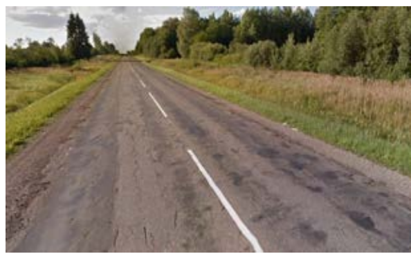
3.31. att. Skats uz autoceļa P131 30. km segumu ( IRI 8,1 mm/m).
