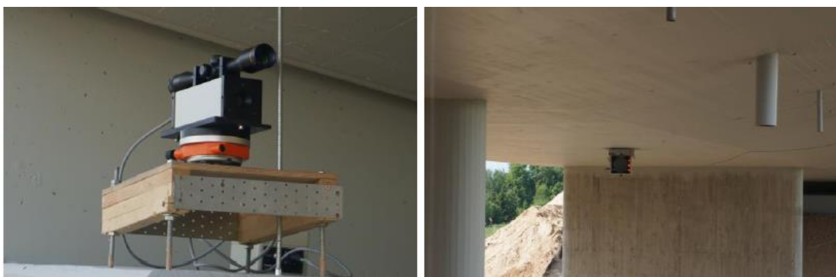
1.8. att. Svārstību sensors Noptel PSM-200 tiek uzstādīts uz tilta pirms pārbaudes ar dinamisku slodzi veikšanas.
