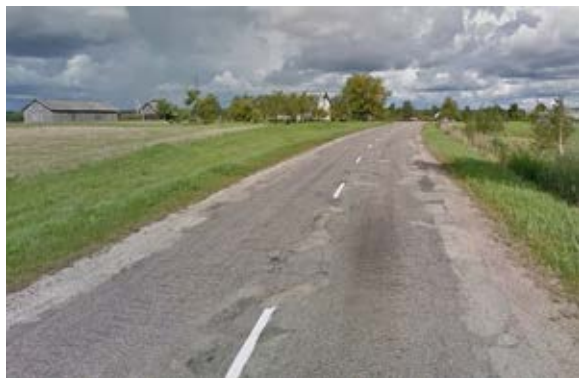
3.28. att. Skats uz autoceļa P22 12. km segumu ( IRI 3,8 mm/m).
