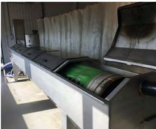
32. attēls. Notekūdeņu dūņu blīvētājs – rotējošs siets
