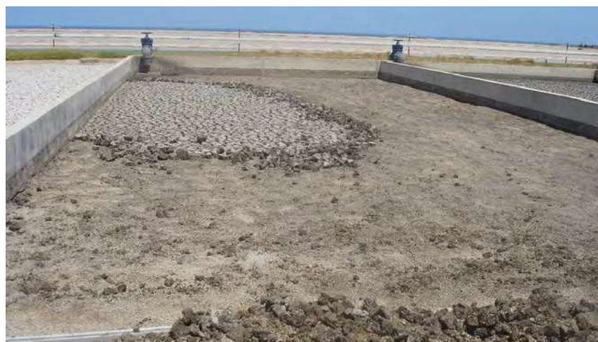
45. attēls. Atklāti notekūdeņu dūņu žāvēšanas lauki 32
