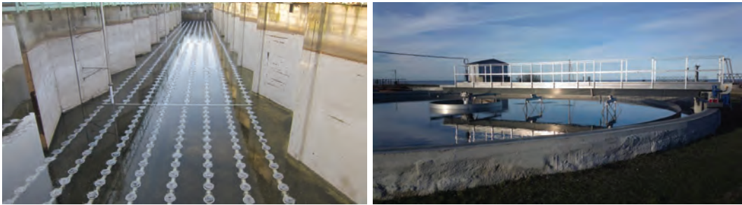
12. attēls. Aerotenci un otrreizējie nostādinātāji notekūdeņu attīrīšanas iekārtās Liepājā, SIA „Liepājas ūdens” arhīvs
