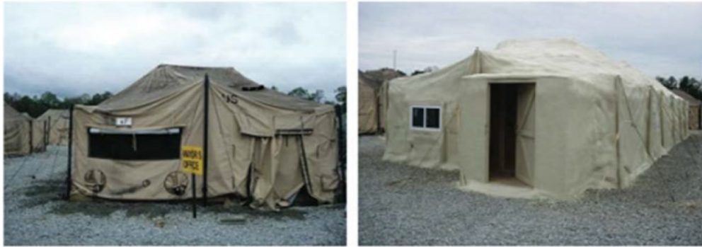
2.6. att. Telts pirms un pēc poliuretāna putu izolācijas ārējās uzklāšanas [59].
