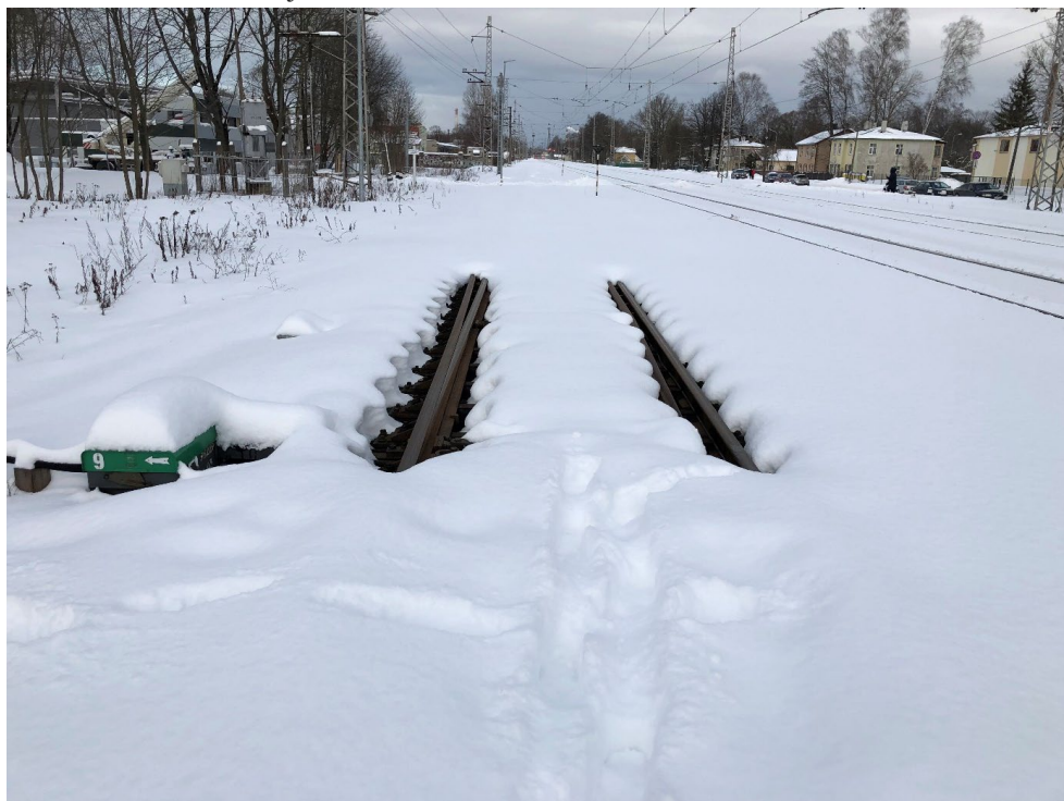
5.1. att. Pārmijas izskats reālos ziemas apstākļos.
