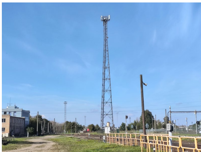
3.25. att. Tele2 2G MST bāzes stacija, izmantotā uztvertā signāla jaudas mērījumiem.
