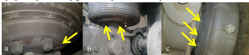
3.27. att. Gumijas korda sajūga sagraušanas paraugi: a – vienas bultskrūves lūzums; b – divu bultskrūvju lūzumi; c – trīs bultskrūvju lūzumi.
