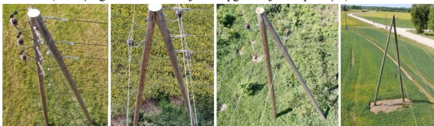
5.12.att. AS “Sadales tīkls” infrastruktūras koka balsta A tipa attēlu piemēri.
