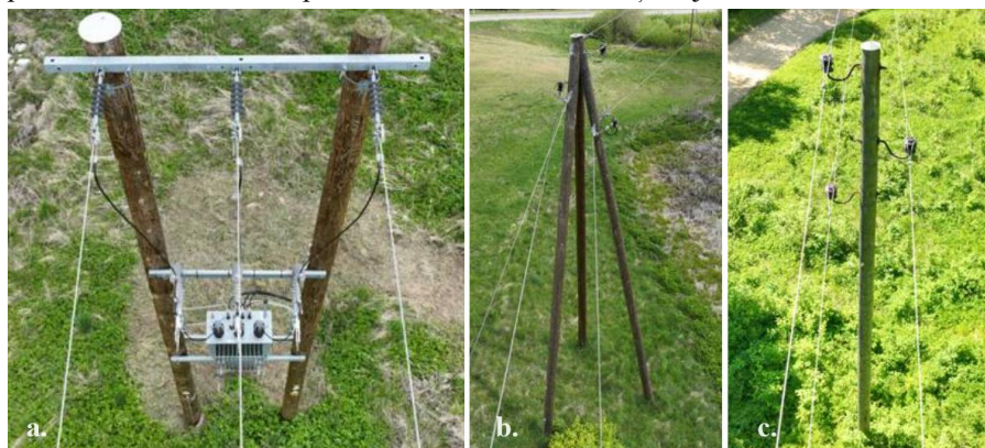
5.3.att. Balstu konstrukciju tipi (a. P tipa koka balsts ar transformatoru, b. 3 kāju koka balsts, c. I tipa koka balsts).
