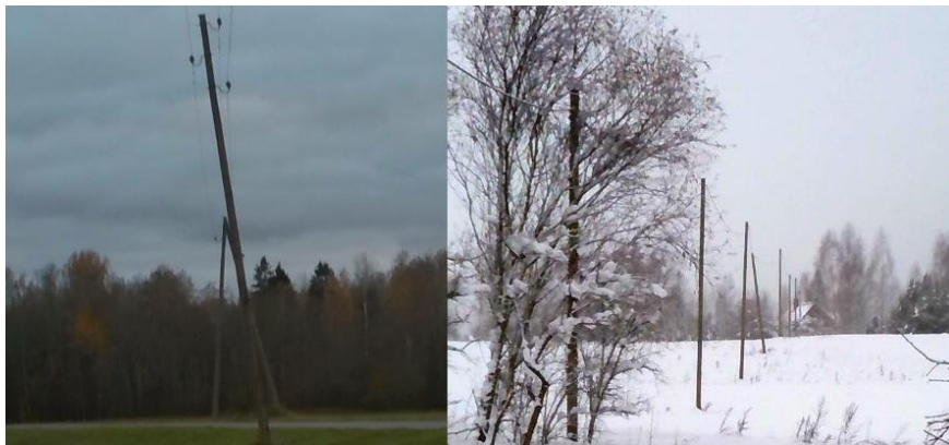
4.12.att. Balstu izsvēršanas piemērs ārpus līnijas ass.
