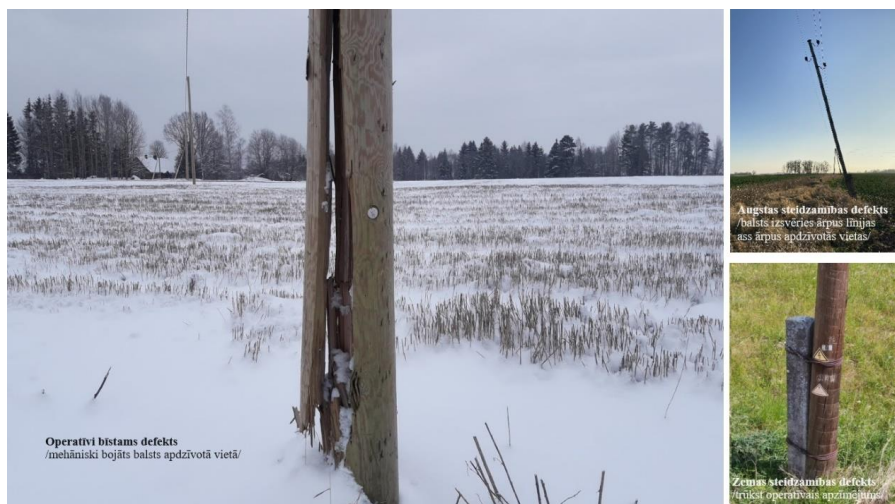
3.5.att. Dažādās steidzamības defektu vizuālie piemēri.
