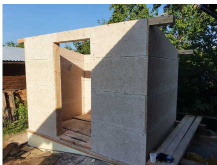
7.13. att. Eksperimentālā stenda vizuālais izskats pēc daudzslāņu paneļu iestrādes pabeigšanas.
