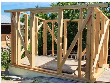
7.11. att. Eksperimentālā stenda koka karkass.
