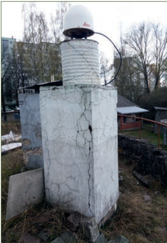
5. attēls. RIGA bāzes stacijas nostiprinājums.
